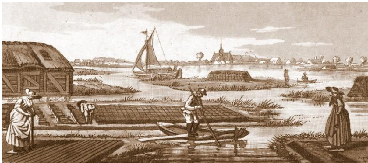
Figuur 41. Natte turfwinning: het veen wordt onder de waterspiegel opgebaggerd en op de aangrenzende landjes te drogen gelegd. Op de tekening is goed te zien hoe het turfgraven in zijn werk ging. Eerst werd de turf onder water opgebaggerd en op het land te drogen gelegd (midden). Daarna werd de slappe veenprut vlak gestampt (rechts) en vervolgens in stukken gesneden (links). Vervolgens werden de turfjes opgestapeld en gedroogd (midden). De turf werd in een turfschuur (links midden) bewaard en werd met een turfschip naar elders vervoerd.
